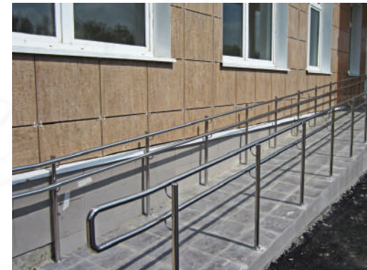
Ограждение пандуса поликлиники со стойками k750 и двойным поручнем Ø38мм из нержавеющей стали.
