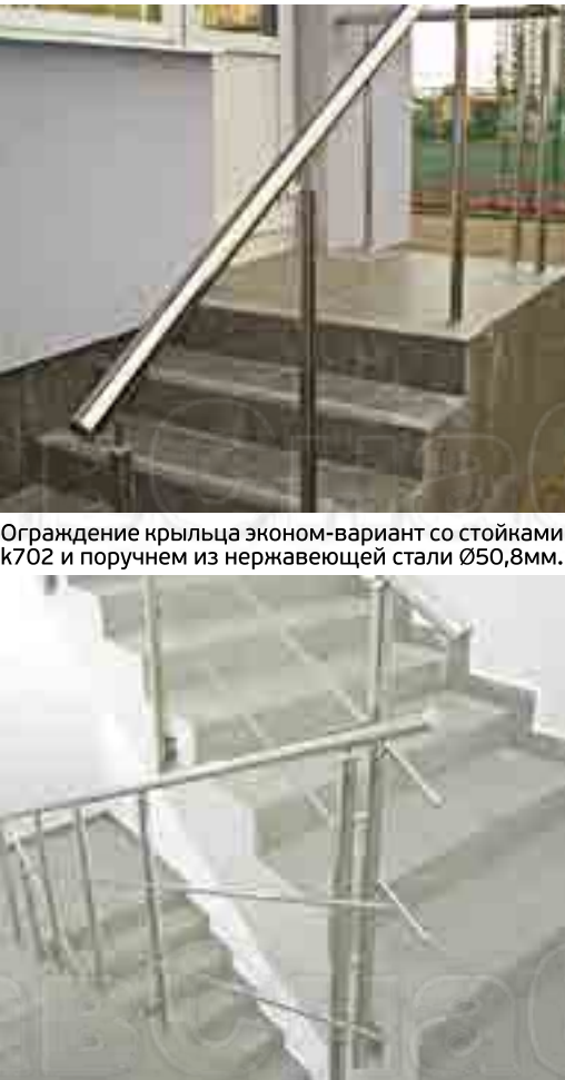
Выбор профессионалов: ограждения со стойками k703 торцевым креплением и 2-мя ригелями – сварная конструкция. Благодаря готовым стойкам скорость монтажа возрастает в 3 раза.
