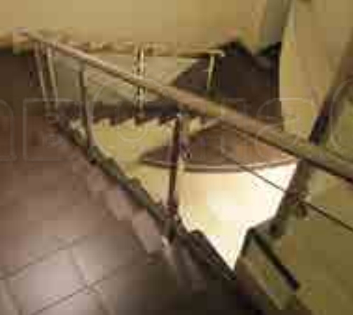
Ограждение «Г» - образной лестницы со стойками k748, прозрачным стеклом 8мм и поручнем Ø50,8мм из нержавеющей стали.
