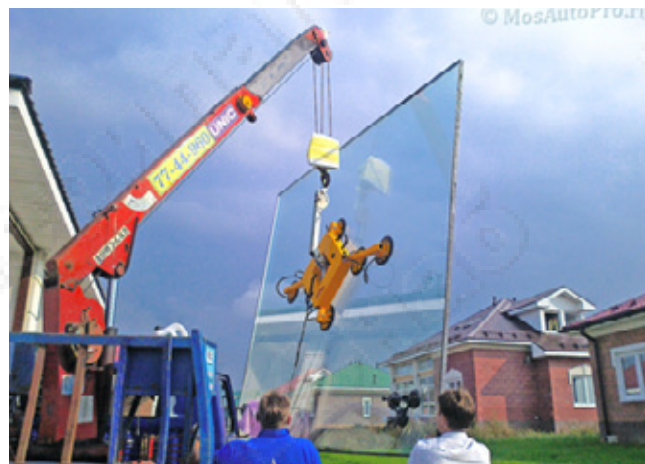
Далее оно снимается краном-манипулятором с вакуумной присоской и поднимается на установленные фланцы.
